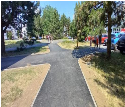
▪ Oprava chodníka Spišské námestie
