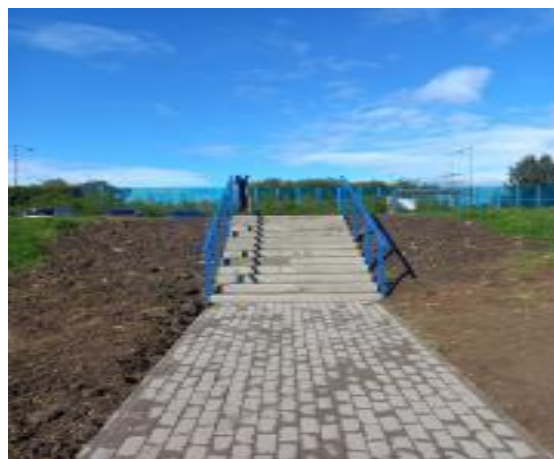
▪ Oprava chodníka - schodiska na Bukoveckej ulici
