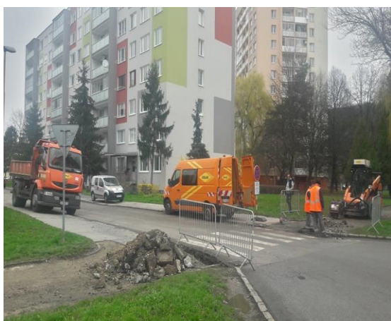
▪ Oprava chodníka na Rovníkovej ulici
