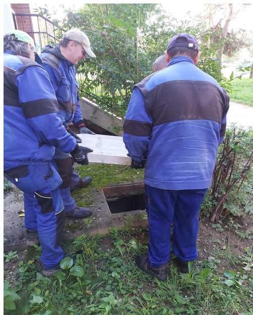
▪ Osádzanie poklopu na kanál
